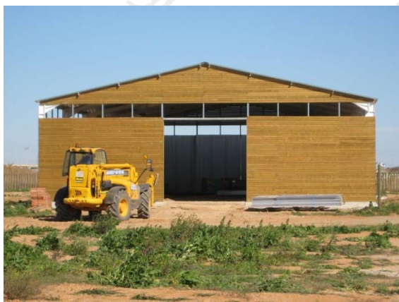
Imagen 9: Nave de mecanización agraria en Agrópolis
