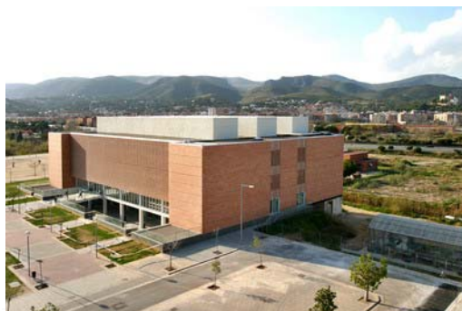
Imagen 12: Edificio de servicios del Campus
