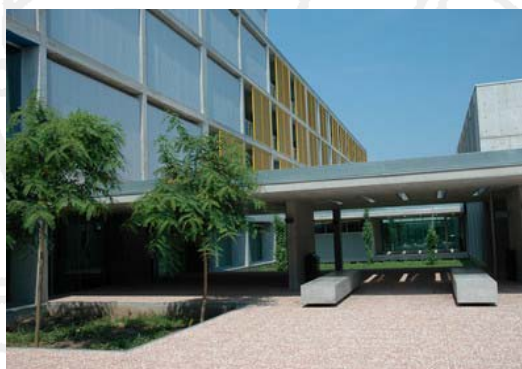
Imagen 2: Vista de la zona de acceso
