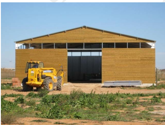
Imagen 9: Nave de mecanización agraria en Agrópolis
