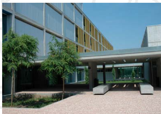
Imagen 2: Vista de la zona de acceso
