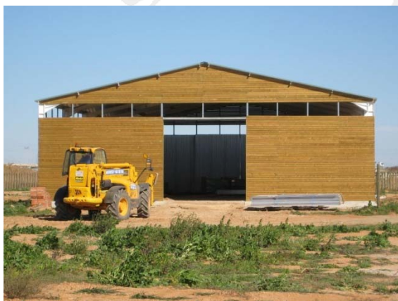
Imagen 9: Nave de mecanización agraria en Agrópolis
