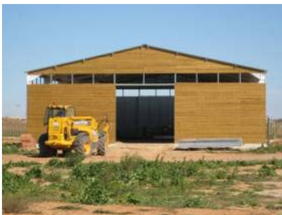
Imagen 3: Nave de mecanización agraria en Agrópolis
