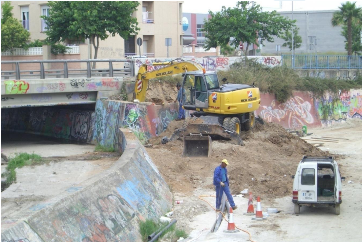
Figura 13. Intersecció Torrents Piera i Pastera. Obres construcció cambra connexions
