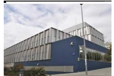
➤ Dues noves infraestructures al Campus de Terrassa
