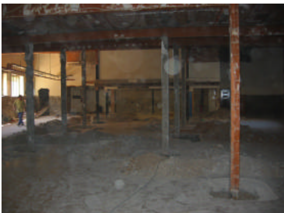
Espai en obres per al laboratori d'aeronàutica (2006)
