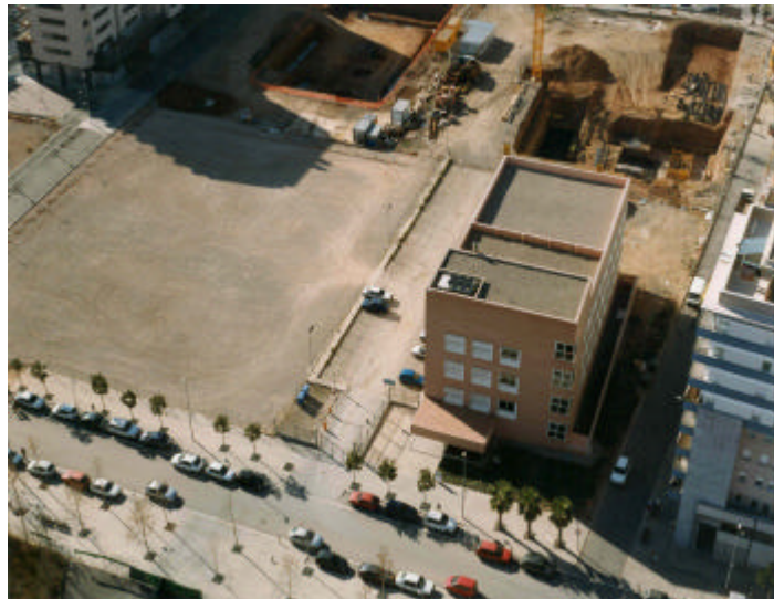
El CITM, al fons, en obres i l'edifici ESII i CD6 recent estrenat l'any 1999
