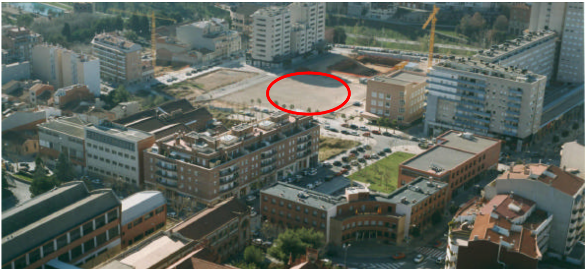
Nou edifici per a la recerca, en construcció
