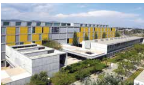
EEABB. Escola d'Enginyeria Agroalimentària i de Biosistemes de Barcelona (Castelldefels) eeabb.upc.edu
