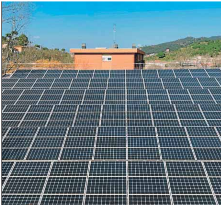
Instal·lació de plaques fotovoltaïques a Catalunya ■ ARXIU
