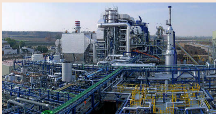
La planta de Les Borges, inaugurada en 2012, fue la primera que combinó la energía termosolar con la biomasa.
