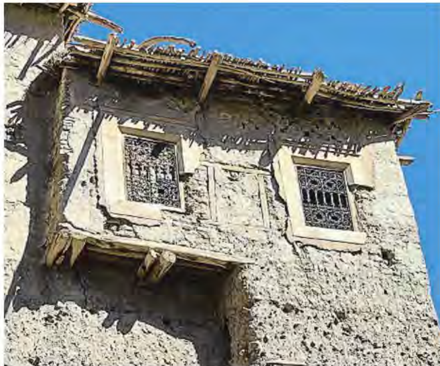
Un edifici construït amb terra i canyes resisteix a la vall d'Aït Bouguemez
