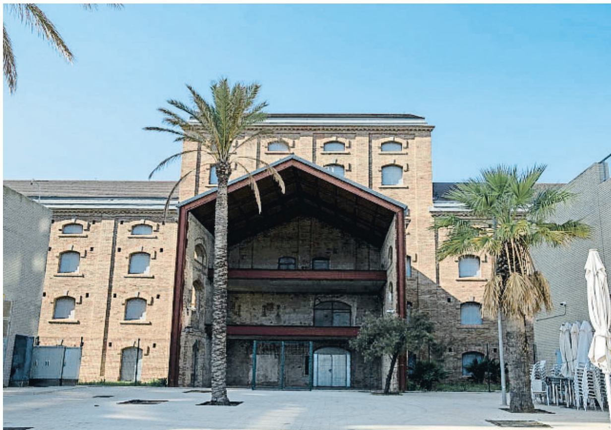
L'edifici fabril de la CACI està ubicat al litoral marítim de Badalona
