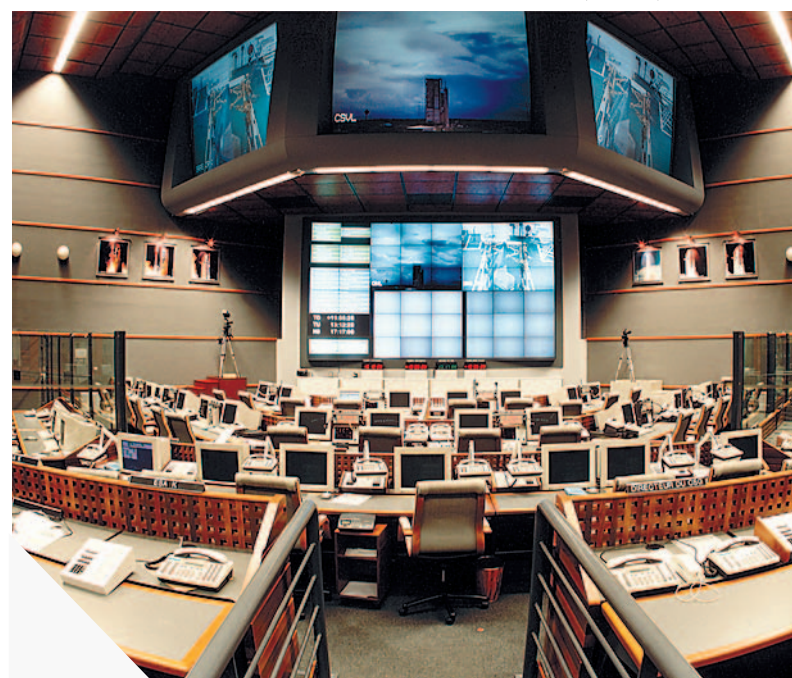
Imatges del Centre de Control de l'ESA a la Guiana Francesa, desenvolupat per l'empresa catalana GTD.
